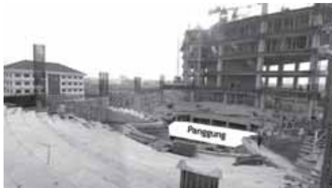
Pembangunan Gedung Konser di Kemayoran
